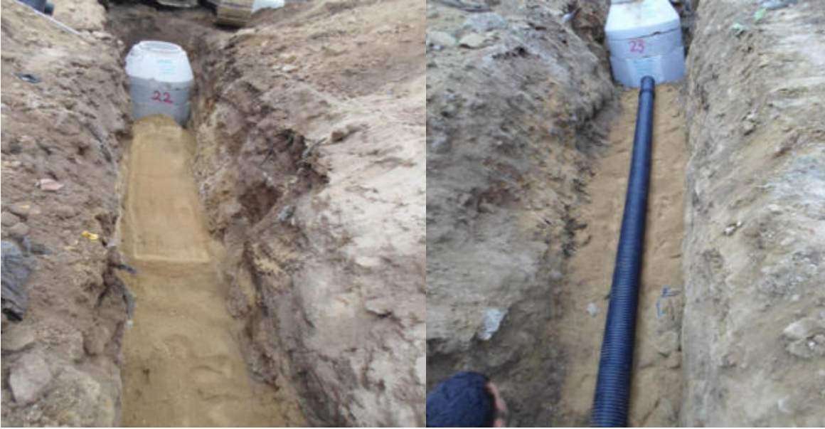
ÇAYAĞZI KANALİZASYON İKMAL İNŞAATI YAPIM İŞİ
