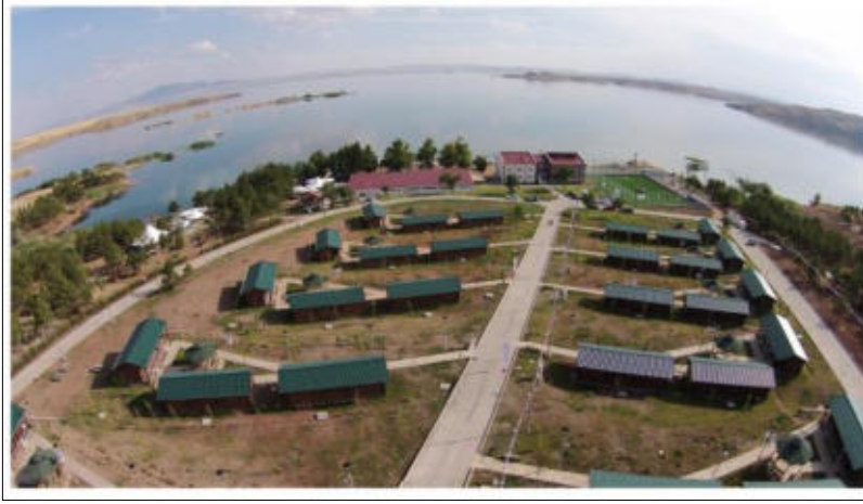
Hirfanlı İzcilik Kampları Modernizasyonu (Kırşehir-Kaman Gençlik ve İzcilik Eğitim Tesisi Tadilat ve Onarım) Yapım İşi
