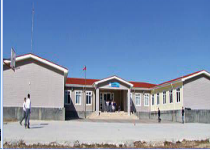
PREFABRİKE GALİP DEMİR İ.Ö.OKULU (8 Derslik)
