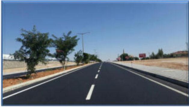
KIRŞEHİR ŞEHİR GEÇİŞİ VE ORGANİZE BAĞLANTISI BSK YAPIM İŞİ
