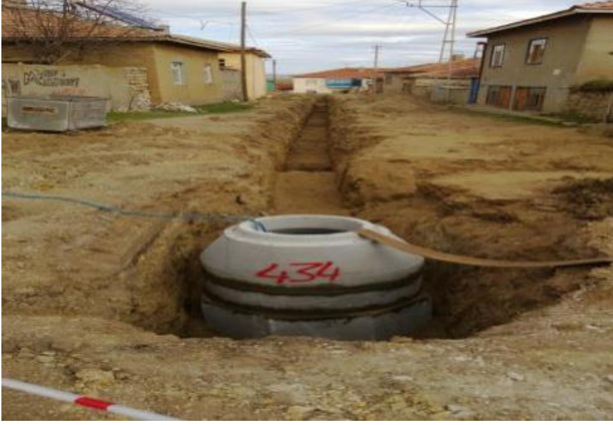
KURANCILI VE DEMİRLİ GRUP KANALİZASYON İNŞAATI
