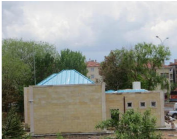
MİLLİ PARK PROJESİ (Aşıkpaşa Tabiat Parkı Yardımcı Bina ve Tesisler)
