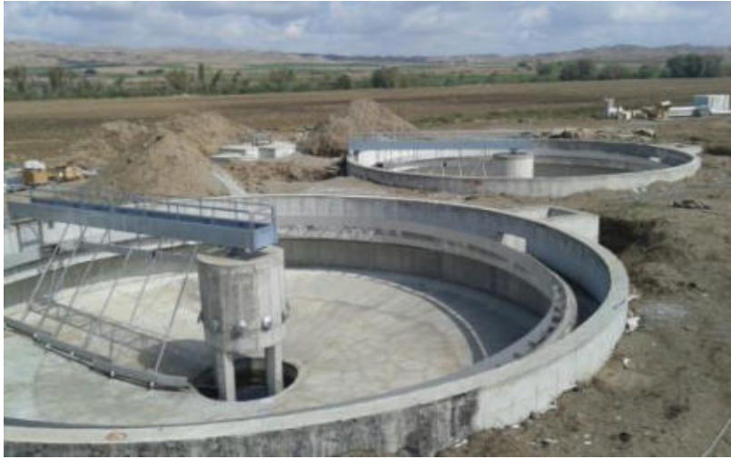
ÇİÇEKDAĞI, KÖSELİ (KIRŞEHİR)-YERKÖY (YOZGAT) ATIK SU ARITMA TESİSİ VE KİSMİ KANALİZASYON İNŞAATI YAPIMI
