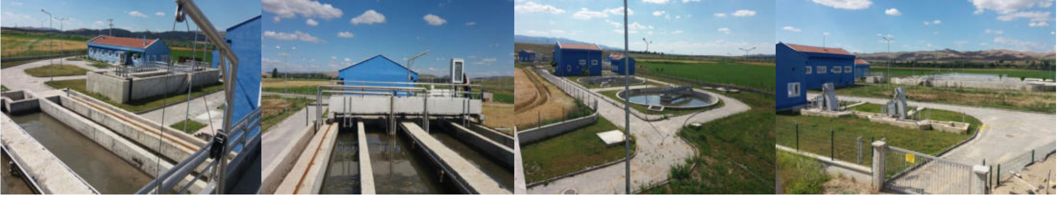
ÇİÇEKDAĞI, KÖSELİ (KIRŞEHİR)-YERKÖY (YOZGAT) ATIK SU ARITMA TESİSİ VE KİSMİ KANALİZASYON İNŞAATI YAPIMI
