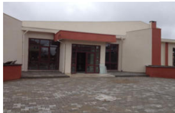
AKÇAKENT KÜLTÜR MERKEZİ (TAMAMLAMA)
